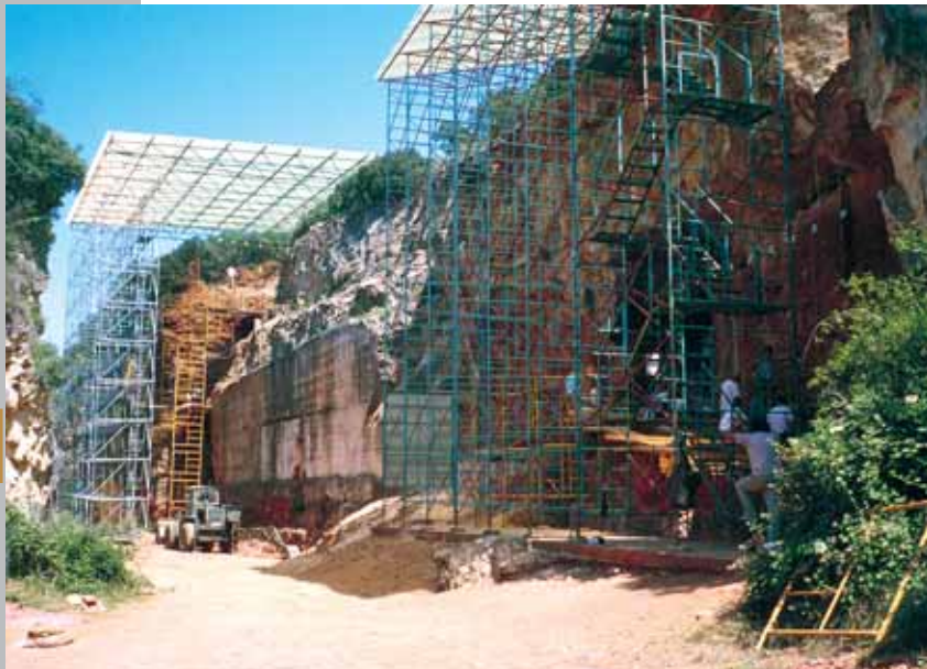
La Trinchera del Ferrocarril.
